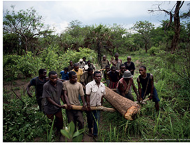
Remettre en état les infrastructures et les axes routiers
