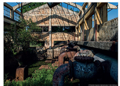
Manono – Des enfants pêchent dans les ruines du barrage de la ville de Manono, construit par la Géomines en 1932.
